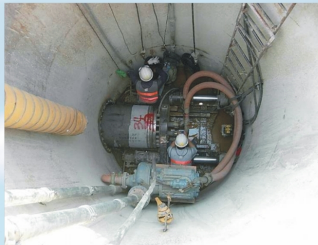
■ 公共汙水管線施工照片
