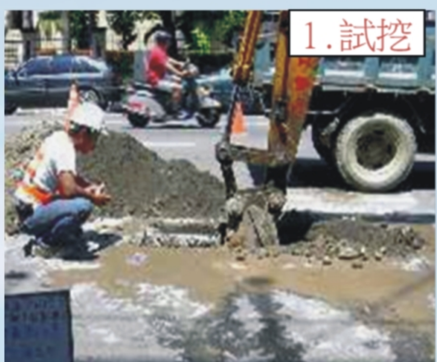
■ 短管推進施工
