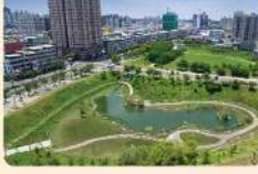
20 寶業里滯洪池
