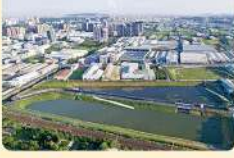
18 鳳山埤滯洪池
